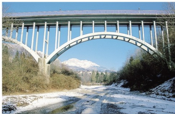
L'elegante ponte in calcestruzzo dell'ing. Luigi Cortese sul torrente Valleggia: allora (1910) all'avanguardia
