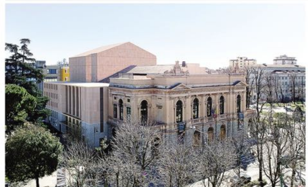
Il rendering mostra come diventerà il teatro Donizetti dopo l'intervento di restauro
